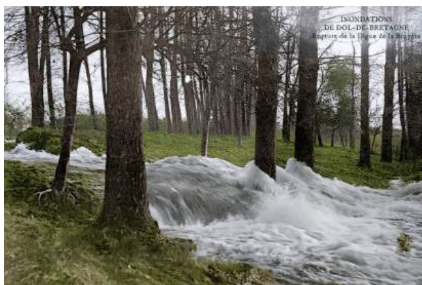
Carte postale de 1910 : Inondations de Dol-De-Bretagne. Rupture de la Digue de la Bruyère.
